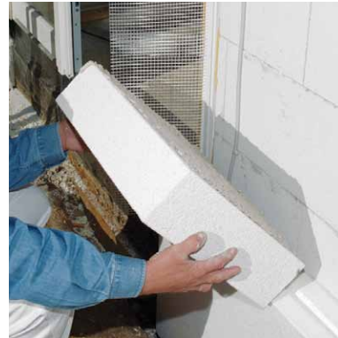
Steghöhe des Klebe- und Armiermörtel ca. 8–10 mm. Unebenheiten im Untergrund bis 5 mm können so ausgeglichen werden.
