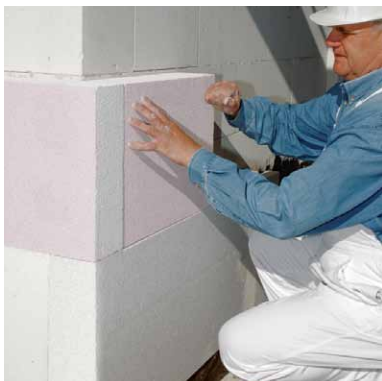
Dämmplatte an die Wandoberfläche andrücken und einschwimmen.
