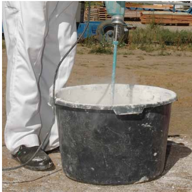
Klebe- und Armiermörtel anrühren. 20 kg ergeben in 8 l Wasser ca. 30 l Klebemörtel.
