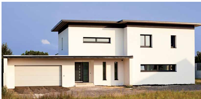
Die Familie Kallinger aus Horitschon dämmte ihr Passivhaus massiv mit 30 cm YTONG als Wandbildner und dem Wärmedämm-Verbundsystem Röfix Minopor – ebenfalls in einer Dicke von 30 cm.
