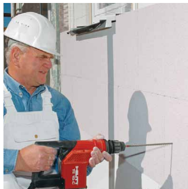
Zusätzliche Befestigung der Multipor Dämmplatten mit geeigneten Dübeln.
