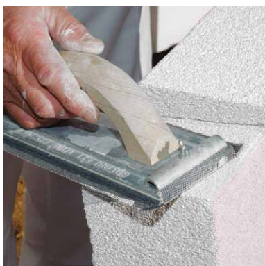
An- und Einbauten passgenau und schnell anarbeiten.
