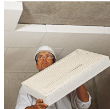
Massive Deckendämmung: leichte Verarbeitung über Kopf. Oberflächen je nach Bedarf streichen oder mit gewebearmiertem Putz versehen. Sicherheit durch nicht brennbares Material.
