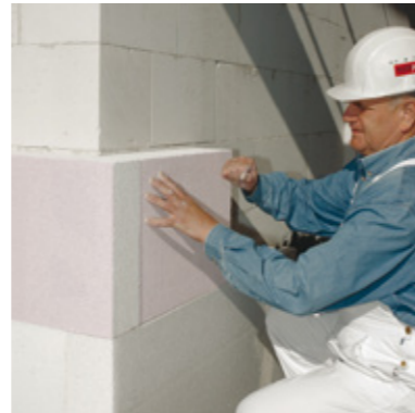
Die Verarbeitung der Multipor Mineraldämmplatten im WDVS erfolgt gemäß Zulassung der jeweiligen Systemanbieter.
