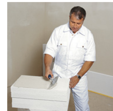
Der Leichtmörtel wird mit der Zahnraufel vollflächig auf die Platten aufgetragen.
