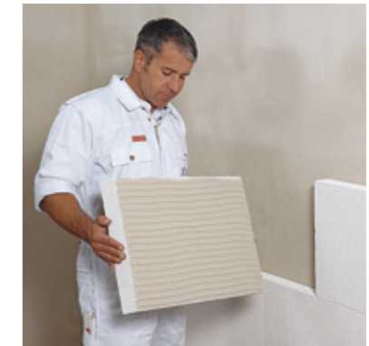
Anschließend wird die Platte einfach auf die Wand geklebt.
